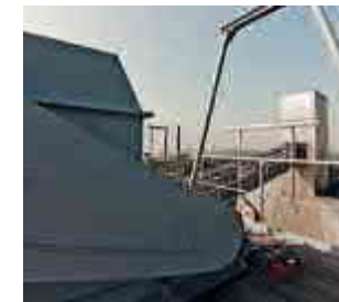
Korrosionsschutzbeschichtung (Dunlop Wittlich)
