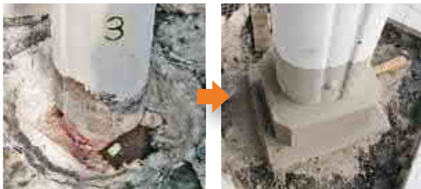
Sanierung tragender Konstruktionen
