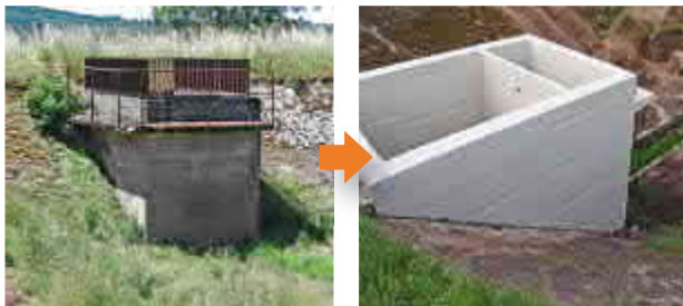
Instandsetzung eines Ringüberlaufbeckens
